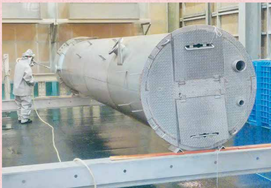
(株)新興工業が施工した長野県 東寺尾・清野間水管橋(画像上)と同社の酸洗工場(石狩市)
