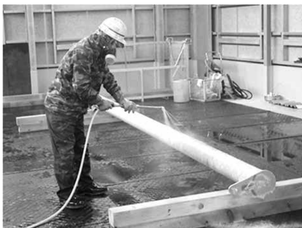
▲ 酸洗液塗布作業の様子
