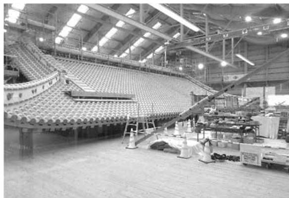
▲ 3階（瓦屋根工事）
