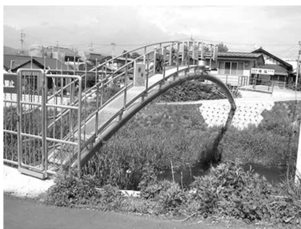
▲ アーチ補剛形式水管橋施工実績(長野県佐久市)
