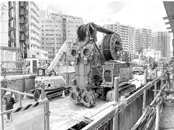
▲ 日本に4台のみのCSM施工機を使用
