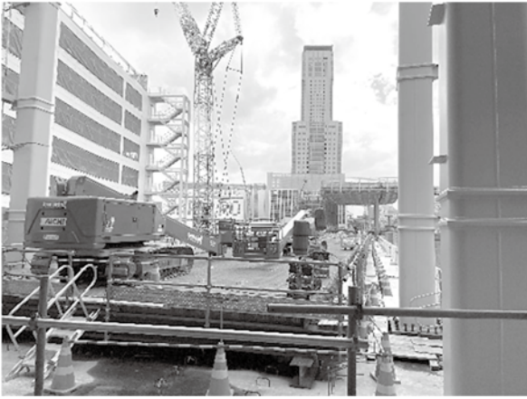
▲ トンネル出口部分
