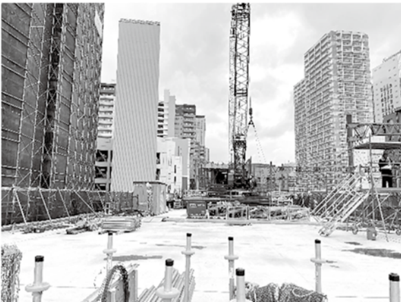
▲ 日本に4台のみのCSM施工機を使用
