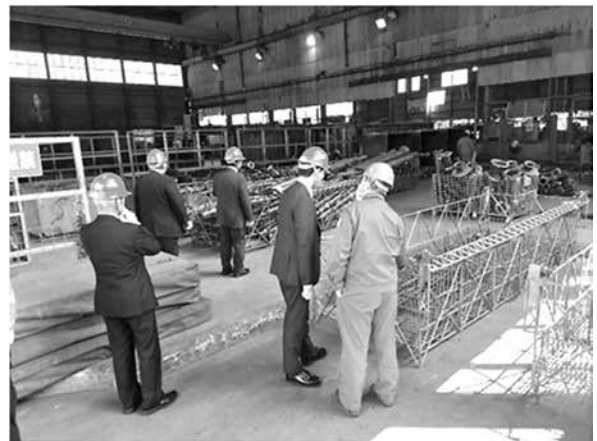
▲ めっき前のストックヤード
